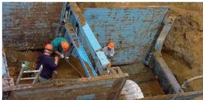
Figura 31 - Blindaggio a cassa di trascinamento (foto)
