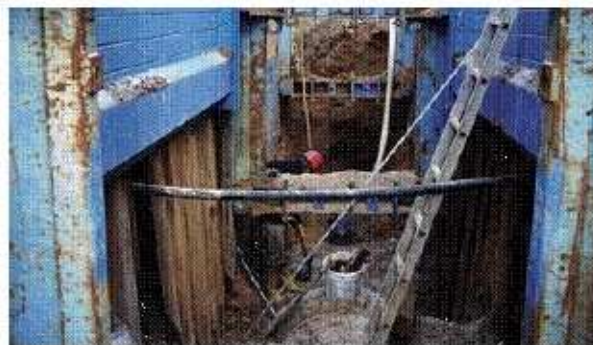
Figura 27 - Blindaggio con cassero porta-palancole (foto)
