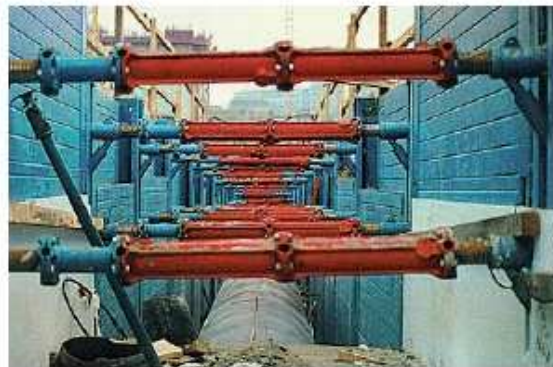
Figura 19 - Blindaggio a due rotore e con due distanziali indipendenti (foto)
